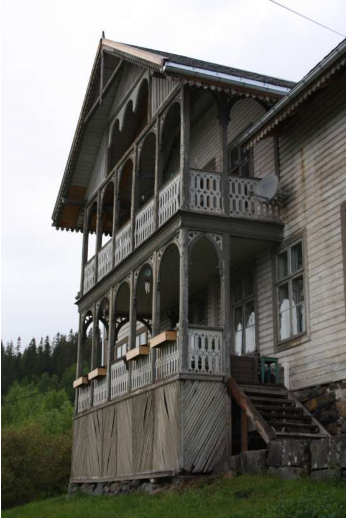
Figur 98. Hovudhuset er bygd i sveitserstil.
