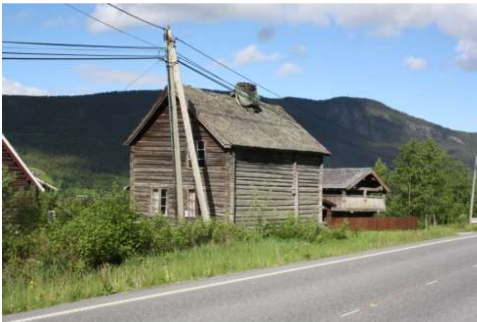
Figur 117. Kårbustad. Mast og leidning ligg heilt inntil bygget
