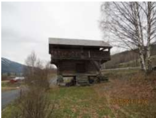
Figur 121. Taktekking, utskifting av treverk, trapp og steinmurar på stabburet er restaurert. Foto: Terje Tvenge
