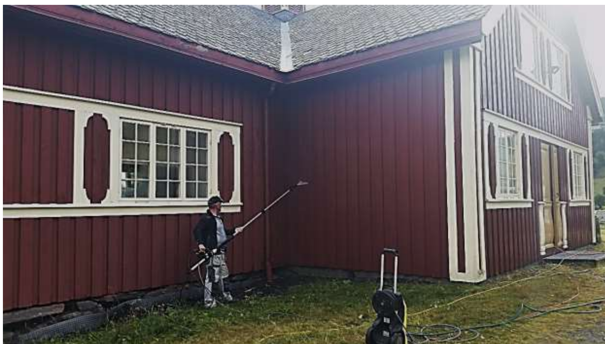
Figur 237. Utvendig vasking av huset hausten 2020
