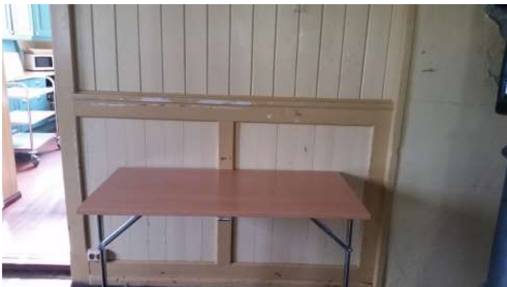
Figur 228. Veggane i salen har brystningspanel
