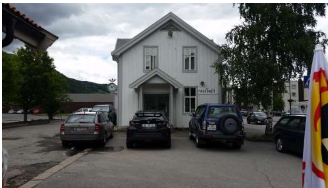
Figur 166. Stasjonsbygningen på Fagernes 2020
