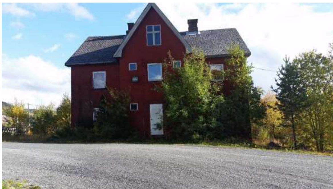
Figur 81. Hus ved Byggmakker med fasade i rappeteknikk og skifertak
