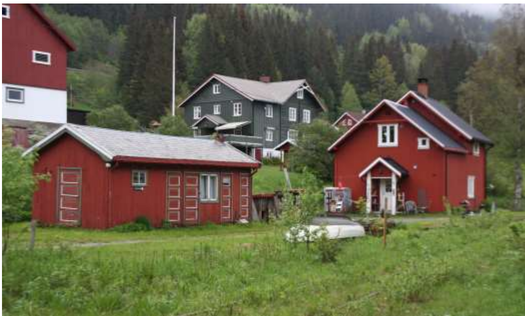
Figur 173. Stasjonsbygningen på Bjørgo er no privat bustad
