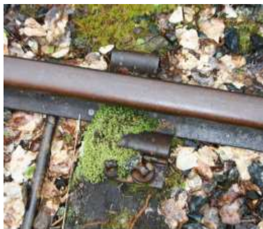
Figur 180. Togliner og skilt finst framleis. Banesporet er i dårleg stand og ueigna til togtrafikk
