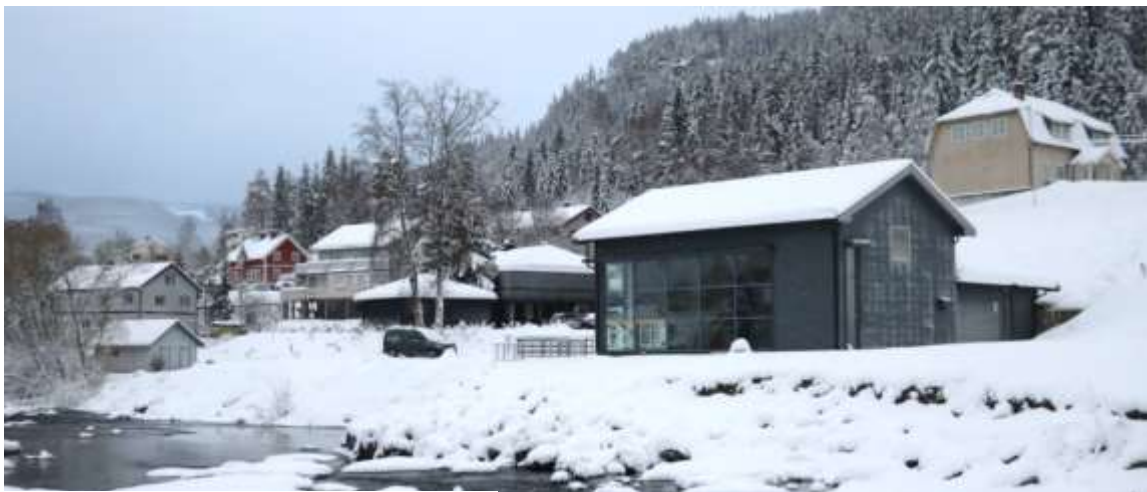
Figur 55. Kraftstasjon (nedst) og gangbru (øvt)
