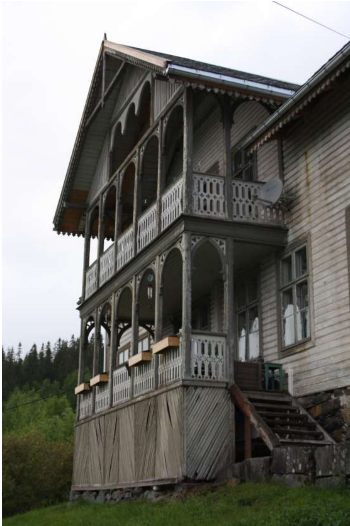
Figur 98. Hovudhuset er bygd i sveitserstil.
