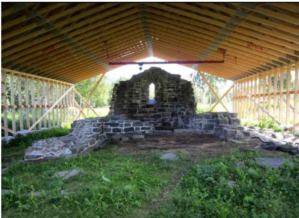
Figur 49. Frå konserveringsprosjektet. Overbygget vart teke ned etter restaurering. Foto: norske-kirkebygg.origo.no
