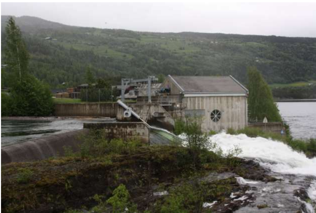
Figur 73. Vasskraft er utgangspunktet for utvikling av Fossheim som industristad. Kraftstasjonen er innreidd som museum.
